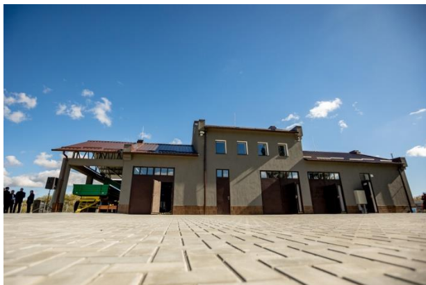
Imagine: Stația modernă de epurare a apelor uzate
