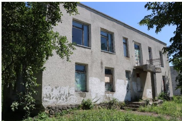
Imagine: Clădirea fostului Liceu nr. 3 (nefuncțional)
